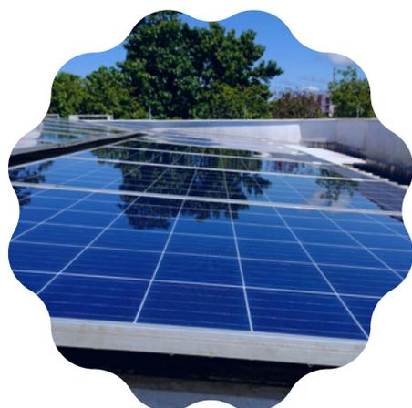
Instalação Residencial. Kit Fotovoltaico 5,30kWp. 16 Módulos de 330Wp. Inversor WEG 5kW. Geração de 516 kWh/mês. Economia de 6.100 kWh/ano.
