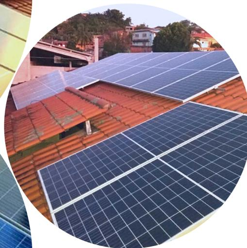
Instalação Residencial. Kit Fotovoltaico 5,52 kWp. 16 Módulos de 345Wp. Inversor WEG 5kW. Geração de 583 kWh/mês. Economia de 7.000kWh/ano.
